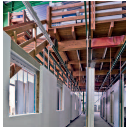
Kurze Bauzeiten durch vorgefertigte Wandelemente.
