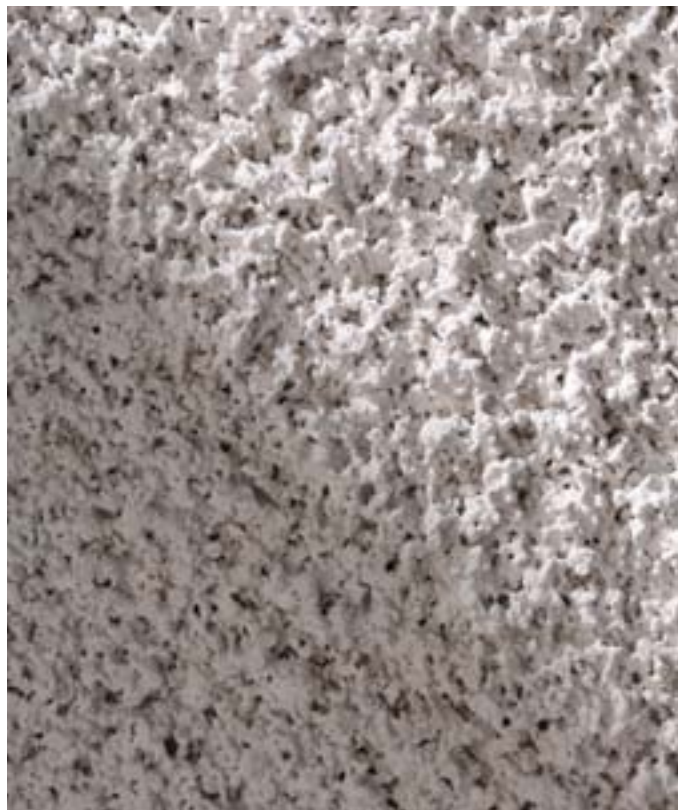
Die unterschiedlichen Oberflächenqualitäten des rauen Sto-Akustikputzes (links) und des sehr groben Sto-Akustik-Spritzputzes (rechts) im Vergleich.
