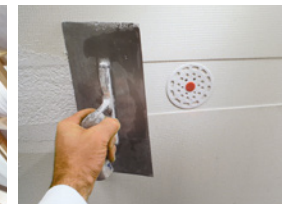
Fassade/WDVS-Sanierung
