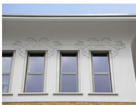
Gefräste Elemente für Fassadengestaltung
