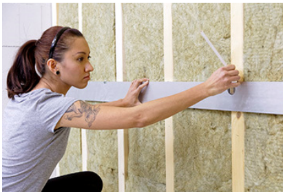
Abmessen der Höhe für die erste Platte und Übertrag des Höhenriss' mit einer Wasserwaage.
